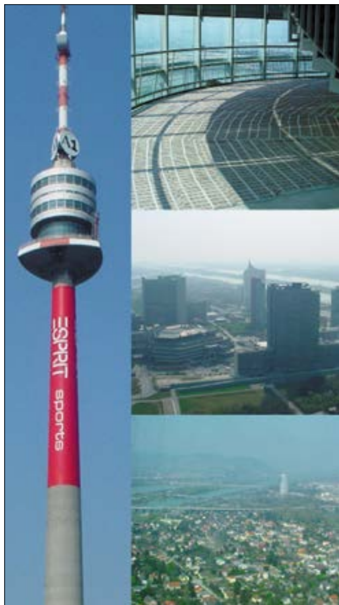
Австрия, Вена Donauturm tower Полное отопление
