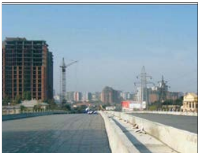
Транспортная развязка, г. Баку Система снеготаяния 8,4 МВт
