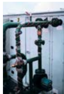
Системы DEVI используют для подогрева или предотвращения замерзания жидкостей в трубопроводах.
