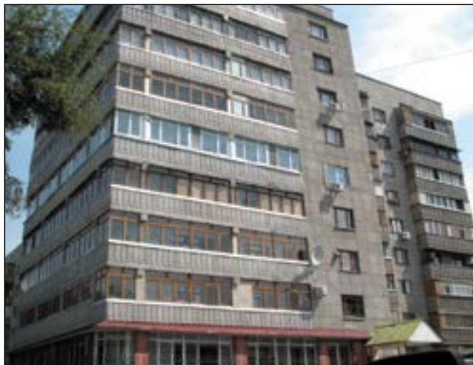
9-ти этажный жилой дом (г. Алматы) Основное отопление всего здания
