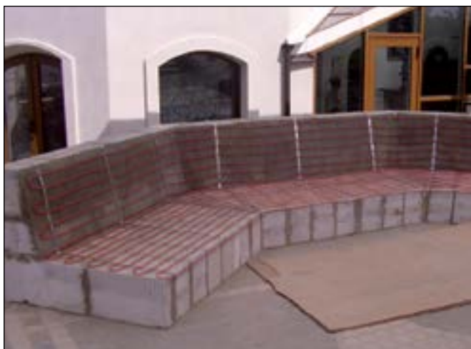
Система уличного обогрева
