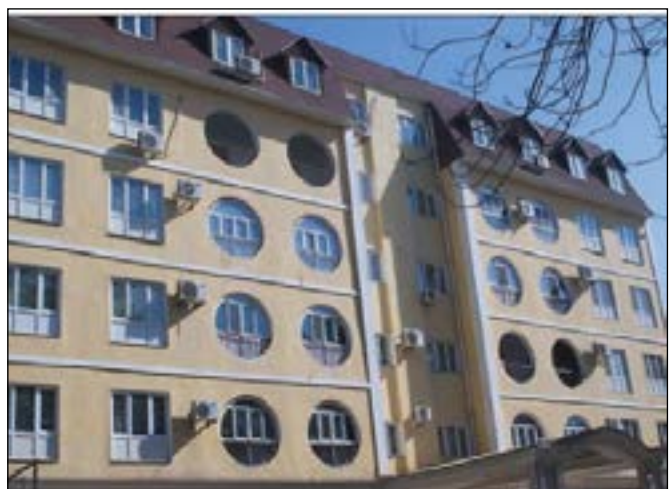
Жилой дом, г. Душанбе Полное отопление
