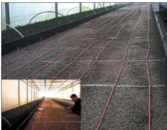
Обогрев грунта в теплице
